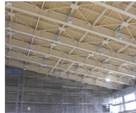
体育館 鉄骨梁
